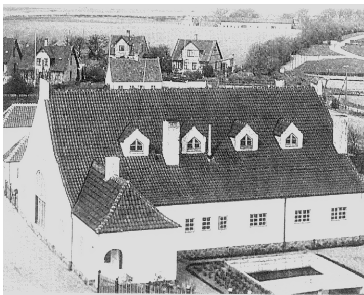
Kerteminde Elektricitetsværk der blev oprettet i 1911
