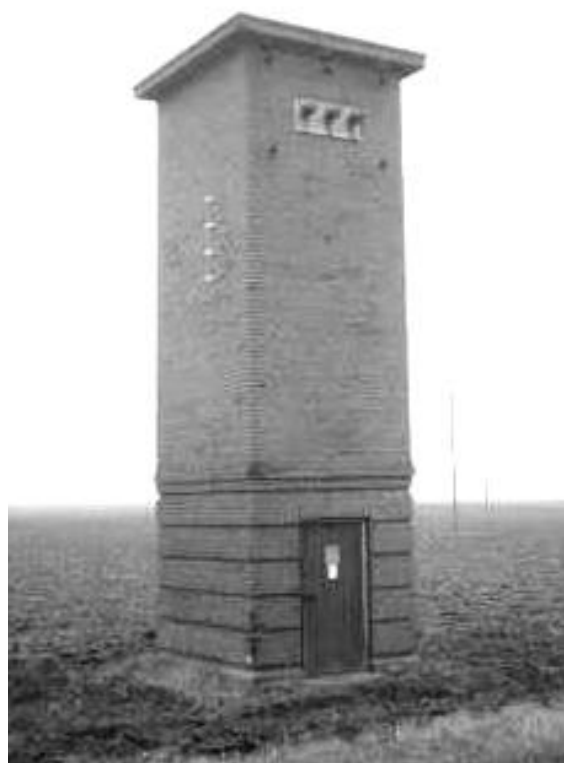
Typisk transformertårn i NEF's område fra 1930'erne. De første transformatorer var placeret på 4 pæle, som antydtes på kortskitserne ovenfor.
