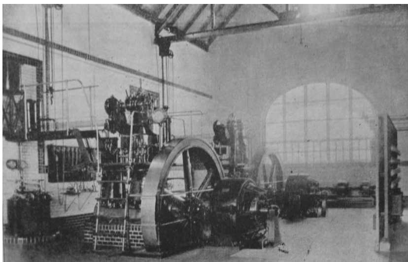
Maskinsalen i Kerteminde Elektricitetsværk 1911
