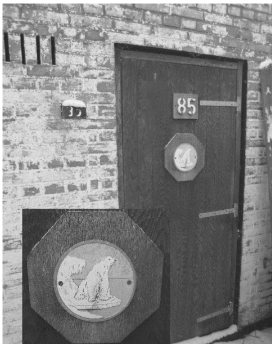
Facaden på det sidste andelsfrysehus i Munkebo ligger på Fjordvej 85 og ejes i dag af politiassistent John Yde-Madsen. Bemærk Sabroe bjørnen på døren (indsat)
