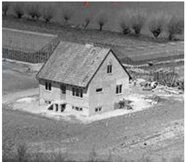
På Krabbegårds sydvestlige lod, matrikel 5d, byggede gartner Jørgen Nielsen en villa, der kom til at ligge hvor den nye Lindøalleen drejede af fra Kertemindevej. Ejendommen blev i 2009 nedrevet og erstattet af den nuværende villa.
