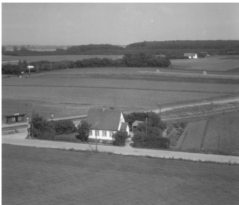
Trællerup holdeplads med læskur og læsserampe
