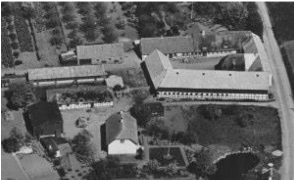
Smedekæret syd for Flettekærgårds areal, hvor smeden byggede hus i 1944. Øverst ses Rosendalsgården.
