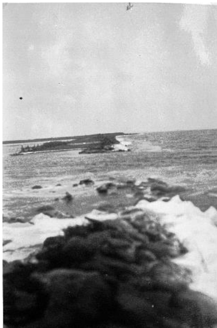
Vandet har skabt et stort gennembrud i diget ved stormfloden i 1945.
