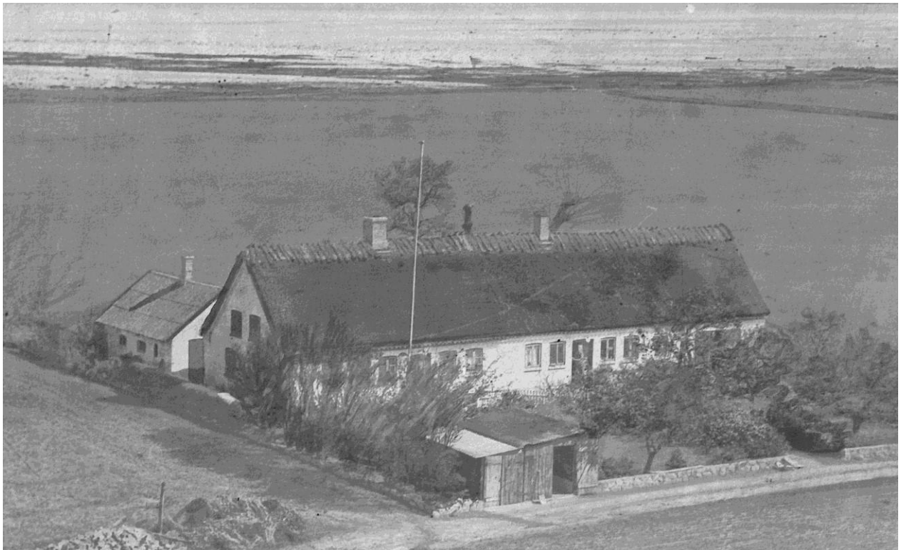
Luftfoto af Boels Bro 9 og 11 fra 1950'erne. Toppen af toldskiltet kan lige anes ved flagstangen, hvorfra splitflaget vajede på officielle flagdage og ved særlige lejligheder. Den nuværende vej helt ned til og langs stranden blev først anlagt da havnen ved Boels Bro anlagdes i 1964. I døren ses Inger Johannesen (1901-1982), den sidste af slægten i huset.
