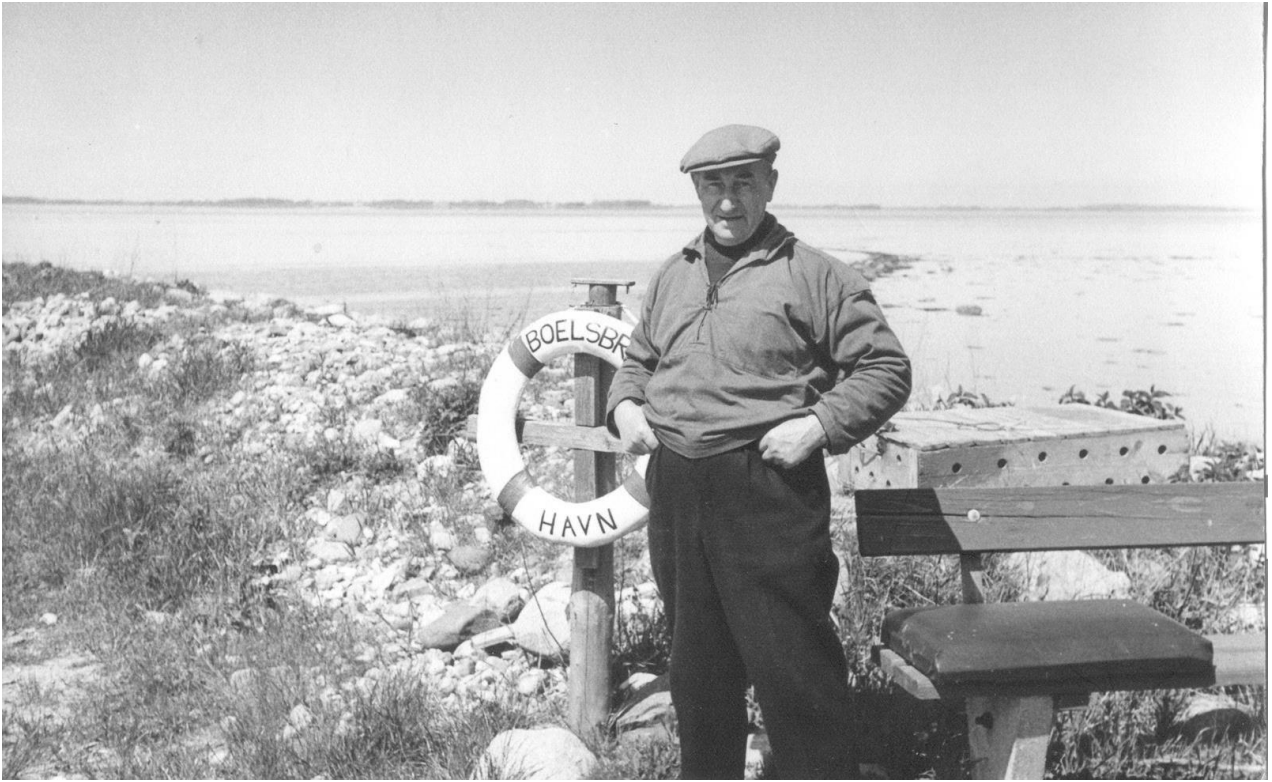
Karl Johannesen, den sidste toldopsynsmand på posten ved Boels Bro. Billedet fra 1970-1975 er taget ved den nye havn ved Boels Bro fra 1964, som afløste den tidligere bådplads.
