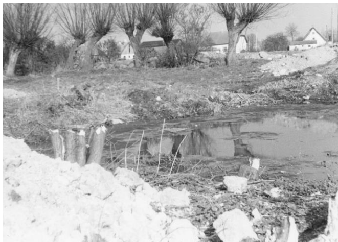
Troelskæret under opfyldning i 1959. I baggrunden "Semco huset" og Flettekærgård
